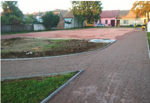
Na hřišti ZŠ Komenského byla provedena kompletní výměna povrchů.
