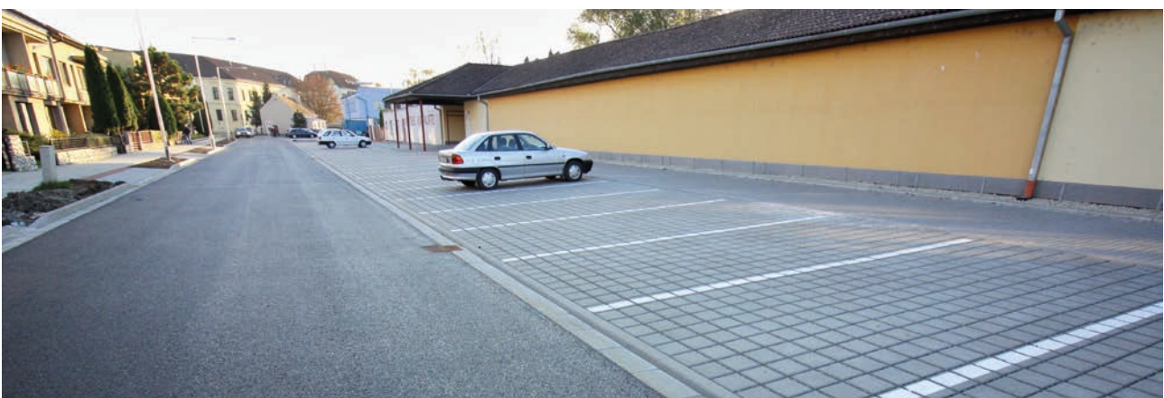
Opraveno bylo rovněž rozměrné parkoviště u břeclavského koupaliště.
